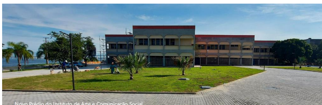
Figura 13: Novos prédios do IACS no Campus do Gragoatá, já em fase final de construção.
