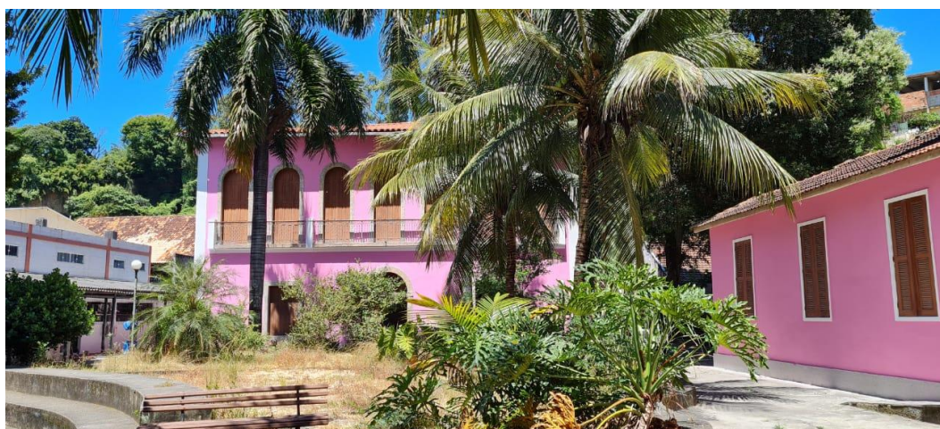
Figura 12 : Sede original do IACS na Rua Lara Vilela, um prédio histórico totalmente reformado.
