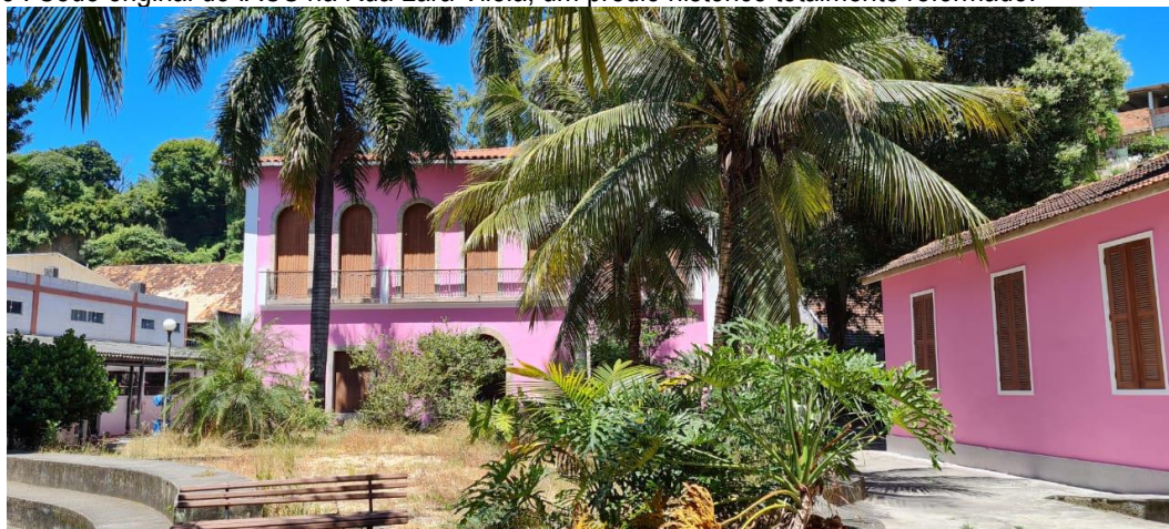
Figura 13 : Sede original do IACS na Rua Lara Vilela, um prédio histórico totalmente reformado.
