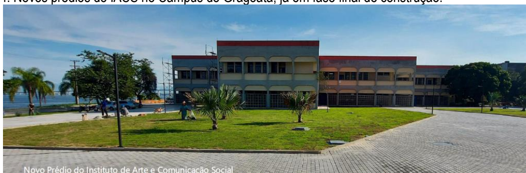
Figura 14: Novos prédios do IACS no Campus do Gragoatá, já em fase final de construção.
